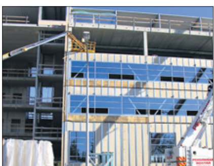
Kiinteistöaskeyhtiö Vanajantie Hämeeenlinnassa.
