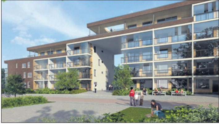
Asunto Oy Espoon Seneca sijaitsee aivan puiston vieressä Klariksentiellä. Arkkitehtuuriltaan Seneca edustaa modernismia parhaimmillaan. Seneca on Asuntosäätiön ja Peab Seicon Oy:n yhteistyössä toteutettava asuintaloyhtiö, jossa on yhteensä 44 asuntoa ja kaikissa on lasitettu parveke tai terrassilasitukseksi varustettu terassi.
