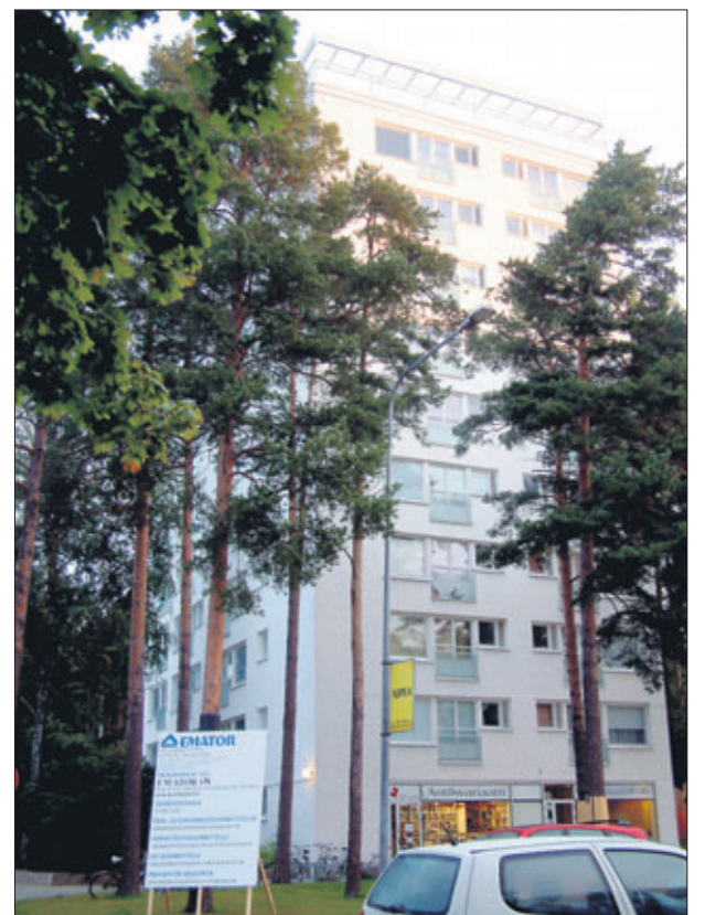
Professori, arkkitehti Aarne Ervin suunnittelemana ja vuonna 1954 valmistuneena As Oy Mäntytornissa Mäntytornilla toteutettiin elokuun 2008 – kesäkuun 2009 aikana hyvin suunniteltu putkistosaneeraus hormisto- ja putkistoelementtejä käyttäen. LVI-töiden lisäksi myös rakennuksen sähköjärjestelmät uusitaan.
