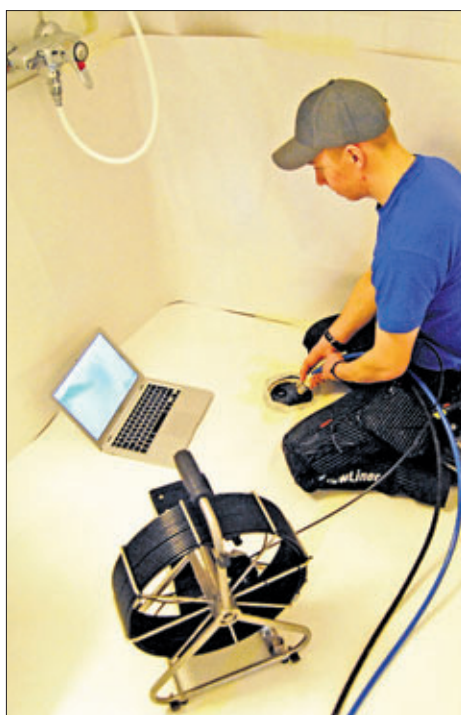
Putkipinnoitus pidentää putkien käyttöikää, kun NewLiner-menetelmällä ruiskuvaletuilla komposiittiputkilla saadaan uudet putket, joiden kestoikä on verrattavissa uusiin, seloittaa Thomas Granberg.
