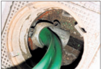
Omega-Liner-muotoputkisujutuksessa uusi putki voidaan asentaa vanhaan viemäriin esimerkiksi olemassa olevan tarkastuskaivoon kautta.
