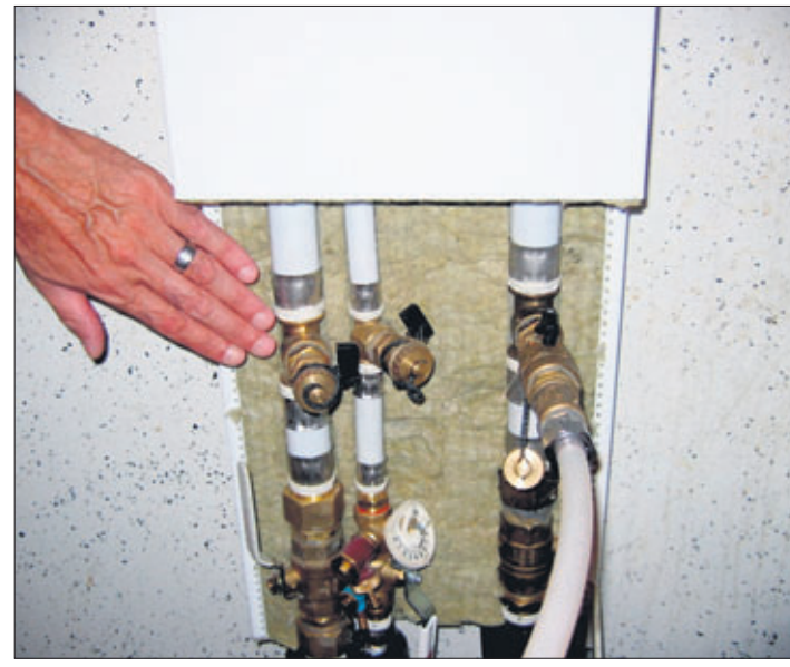
As Oy:n Tornitalossa putkistosaneeraus toteutetaan Uponor-komposiittijärjestelmän käyttövesi- ja viemäriputkilla asennettuina PipeModulin AS-elementteihin . Uudet putket ja johdot verhoetaan siisteihin sisustuselementteihin. Kuva: Juha Karila.
