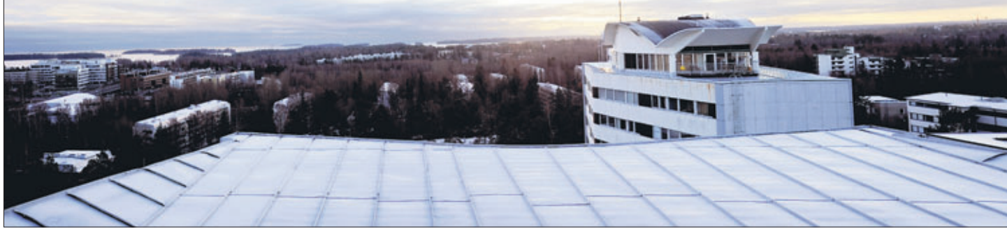
As Oy Tornitalon rakennus on arkkitehti Viljo Revellin suunnittelema arvorakennus, jossa on 48 asuntoa. Panoraamakuva Taskumattalojen ylimmästä kerroksesta. Kuva: Kai Kuusisto.
