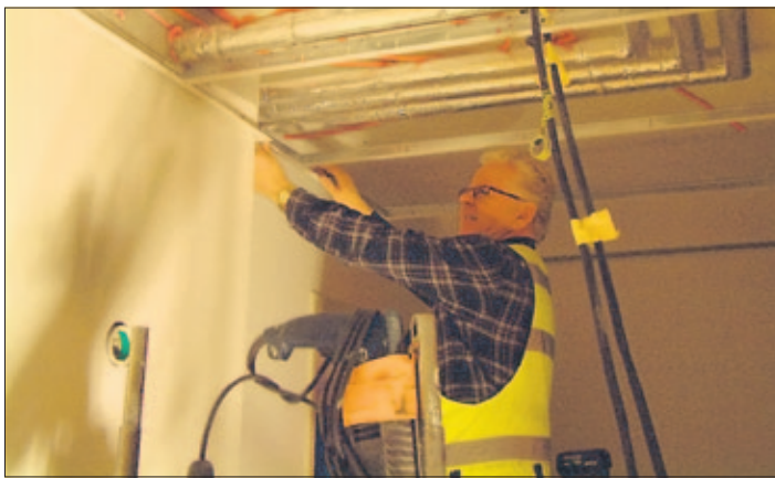
Veli Albrecht viimeistelee vesijohtojen koteloinnin porraskäytävien katon. Tällä tavalla ne on helposti huollettavissa ja ne sijoitetaan katon välilätkän yläpuolelle.
