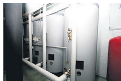
Taloyhtiön tiloihin kätevästi asennettavat käyttövesivaraaja ja uusi lämmönjakokeskus.
