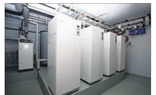
Taloyhtiön tiloihin kätevästi asennettavat käyttövesivaraaja ja uusi lämmönjakokeskus.
