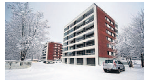
Heinolassa, Tommolän kaupungin osassa tehtiin joulukuussa 2010 As. Oy Tommolän Säästötorin -taloyhtiön erittäin edistykseellinen lämmitysjärjestelmän saneeraus.
