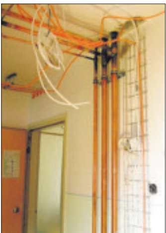
Vesijohtojen kupariputket asennetaan koteloon.
