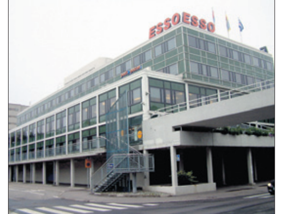
ST1 on jättänyt asemakaavan muutoshakemuksen koskien Kuitinmäen ostoskeskuksessa sijaitsevaa Esson entistä, tyhjillään olevaa pääkonttoria osoitteessa Kuunkehrä 6. ST1 haluaa tonteille asuntoja.
