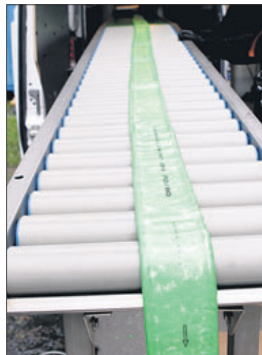
Sukituksessa joustava sukka kyllästetään epoksihartsilla. Manikeliin avulla epoksihartsia levitetään tasaisesti ennen viemäriin asentamista. Näin varmistetaan että sukan kovettuessa vanhaan viemäriin muodostuu tasalaatuinen uusi viemäriputki.
