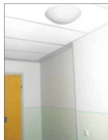
Rappukäytävä on tyylikäs ja vesiputket on sijoitettu koteloihin. Tulevaisuudessa ne on helpoa huoltaa.
