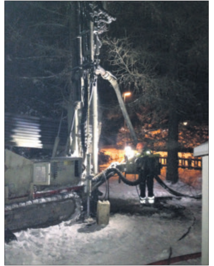
Omakotitalon 200 m syvyisen energiakaivon poraus käynnissä, joka toteutettiin Rototec Oy:n toimesta tehokkaasti puolessatoista päivässä.
