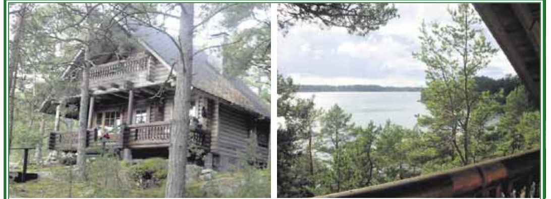
Hirsihuvila kahdessa kerroksessa.
