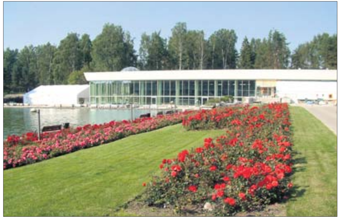
Uudistunut Tapiolan uimahalli avaa ovensa lokakuun puolivälin tienoilla.
